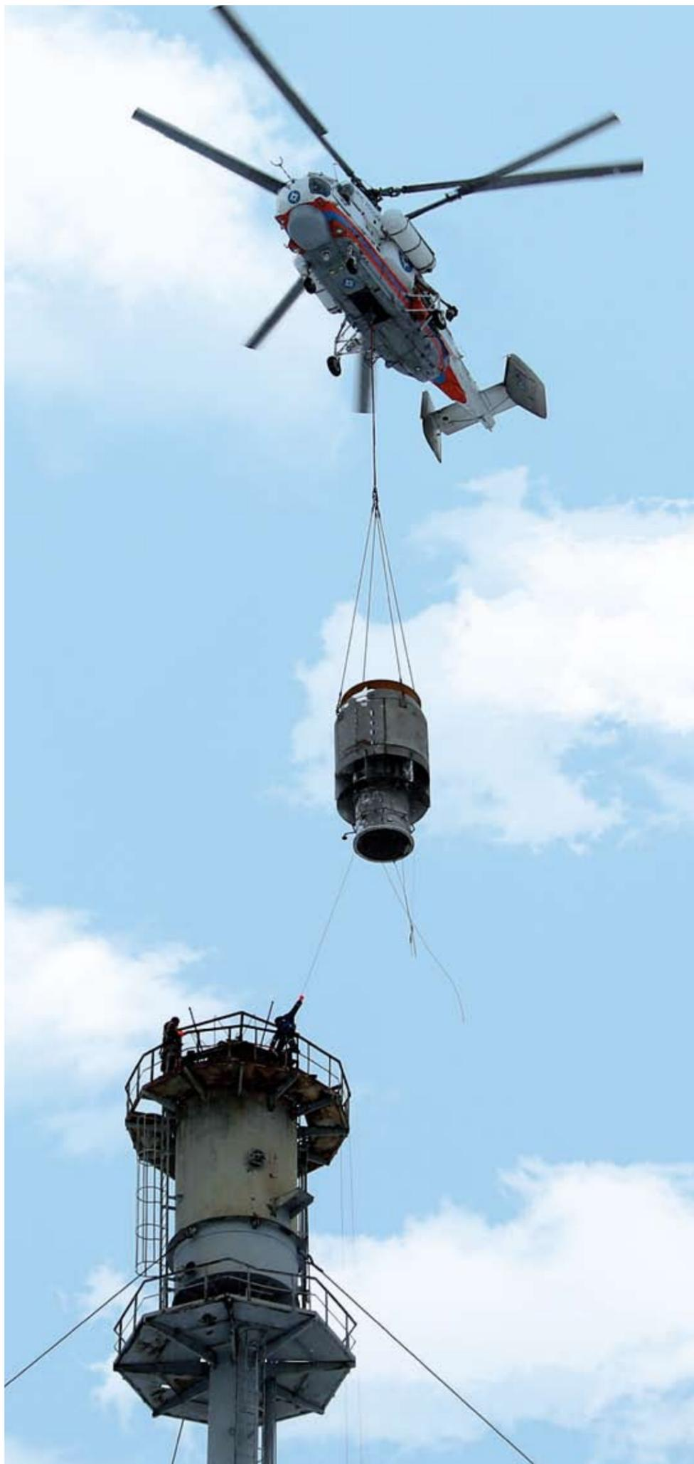
Это уже вторая замена оголовков факелов с помощью вертолета на газоперерабатывающем заводе. Впервые оголовок в рамках программы по оптимизации факельной системы был заменен здесь летом 2014 года
