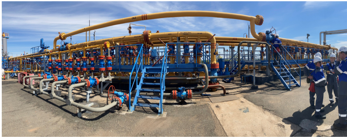
На установку комплексной подготовки газа №14 для первичной подготовки поступают углеводороды более чем со ста скважин.
