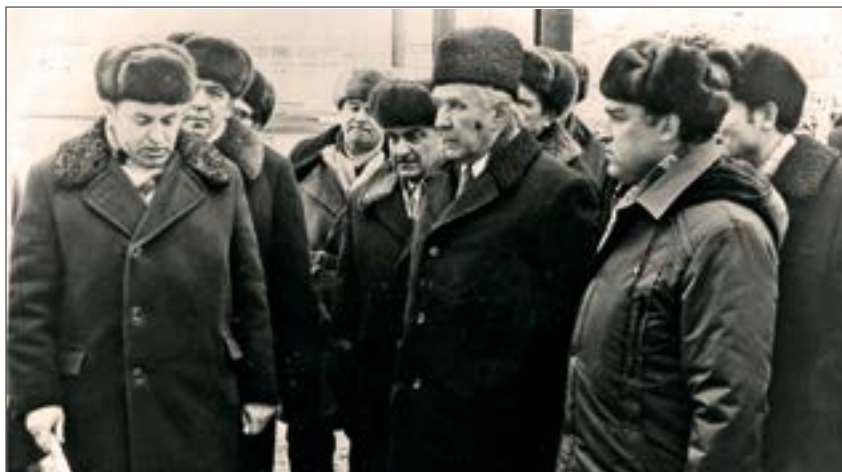
А.Н. Косыгин, В.С. Черномырдин на строительной площадке ГПЗ, 1970-е гг.
