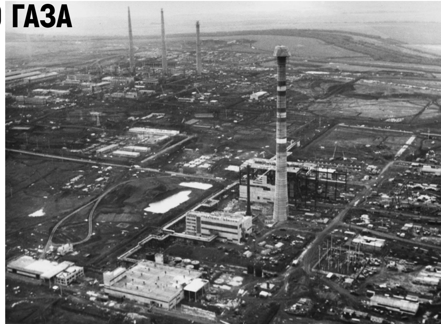
Панорама строительной площадки ГПЗ, 1976
